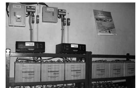
links: Eröffnung des DESI Ausbildungsprojekts, Studenten mit den beiden Lehrern und Jakob Schaub (links). oben: Anbringung der Solaranlage auf dem Dach des Dipshikabüros in Gono Aloy, Rudrapur; Batterieanlage mit Umformer
