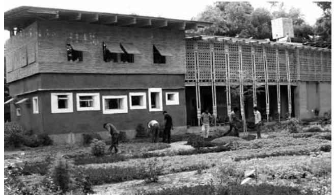
Vielbewundertes Schulhaus für die Elektrikerausbildung
