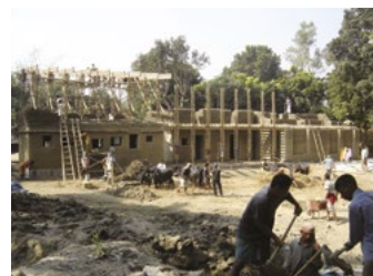
Bau des DESI-Schulgebäudes.
