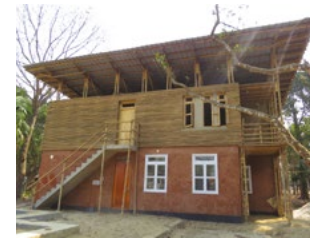
METI Lehrer*innen-Wohnungen kurz nach Fertigstellung 2020/21.
